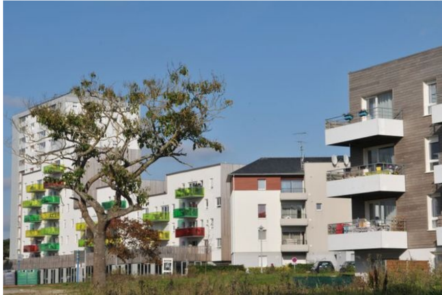
Rénovation urbaine de Kervénanec
