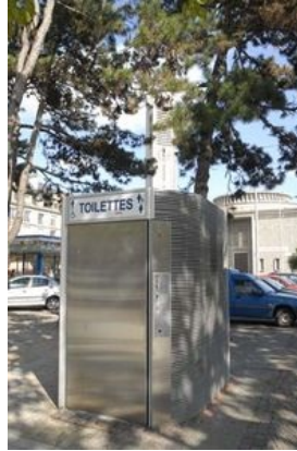
Toilettes publiques, place Alsace Lorraine
